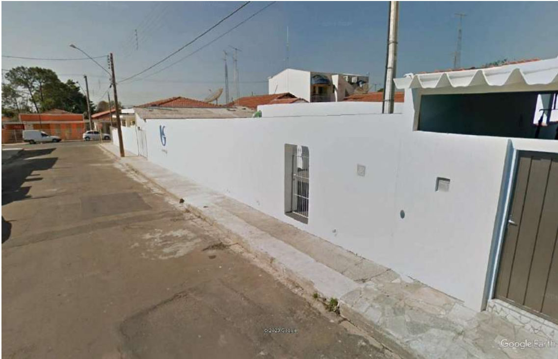
Figura 27 - Detalhe do reservatório 06 (Campacci) na sede do município. Fonte: Google Earth (2011)
