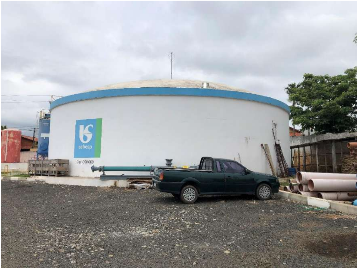
Figura 25 - Detalhe do reservatório 03 (ETA) na sede do município
