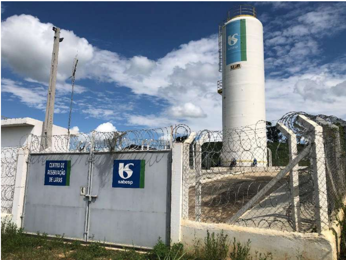
Figura 35 - Detalhe do reservatório 04 do Distrito de Laras
