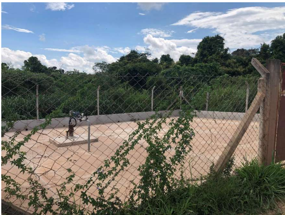
Figura 13 - Detalhe do Poço P4 do Distrito de Laras
