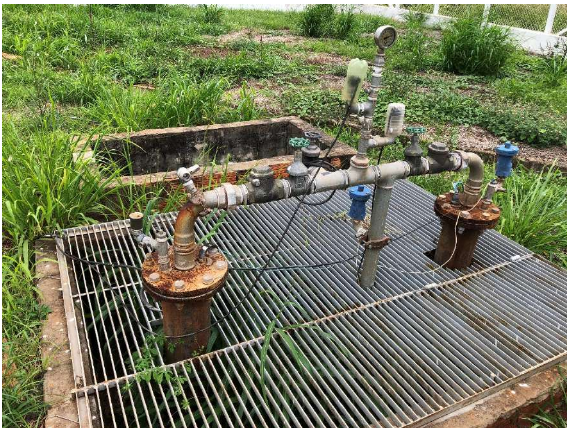
Figura 18 - Detalhe Booster Três Carolina – abastece o bairro Três Carolinas no Distrito Maristela
