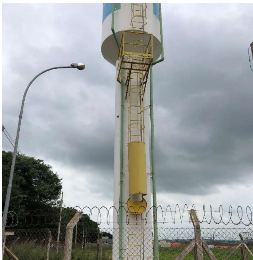
Figura 31 - Detalhe do reservatório 03 do Distrito de Maristela
