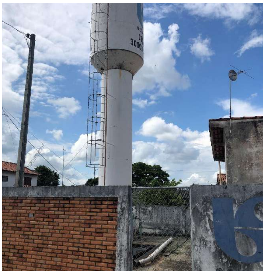
Figura 34 - Detalhe do reservatório 03 do Distrito de Laras
