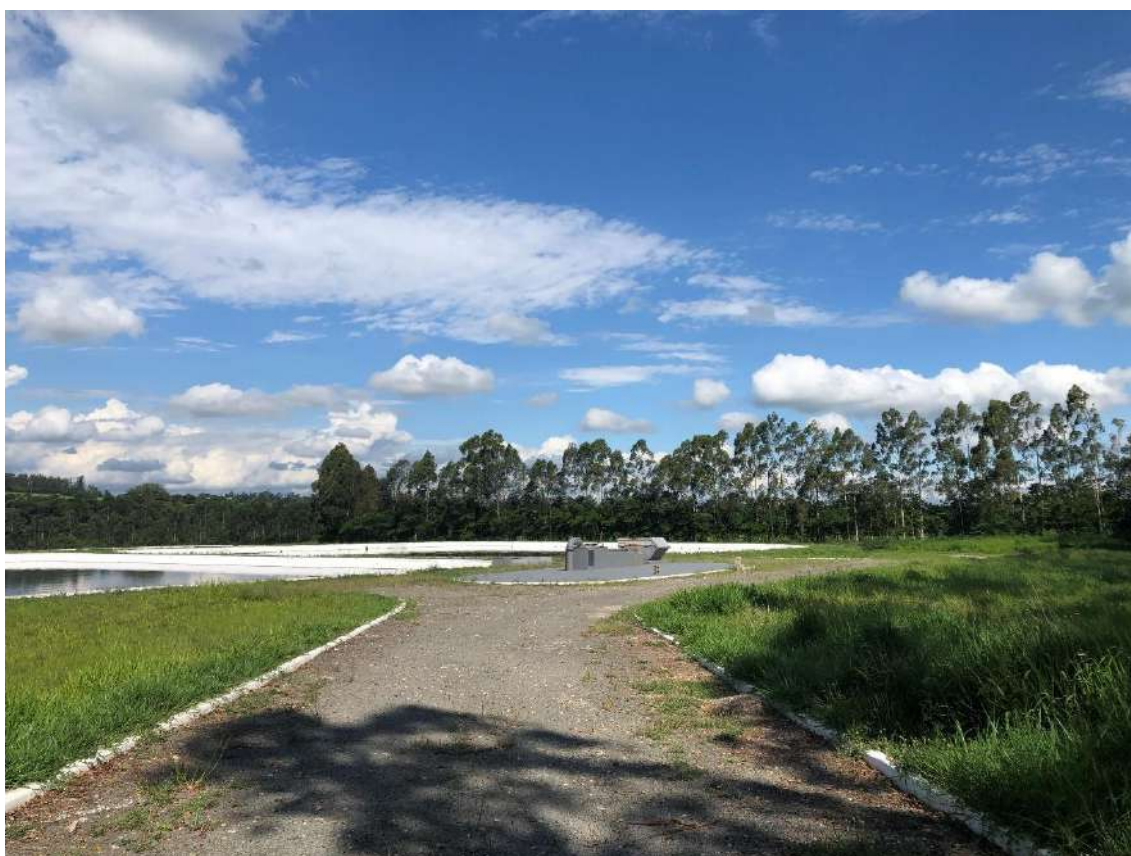
Figura 40 - Detalhe da ETE Laranjal/Maristela do SES Sede
