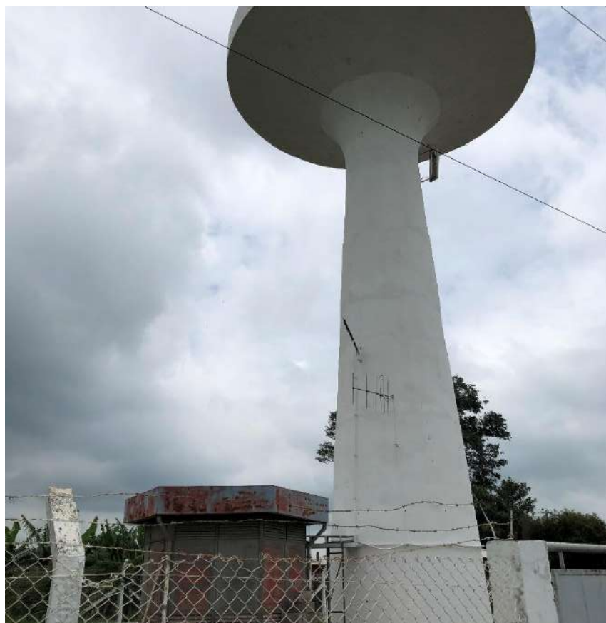
Figura 29 - Detalhe do reservatório 01 do Distrito de Maristela
