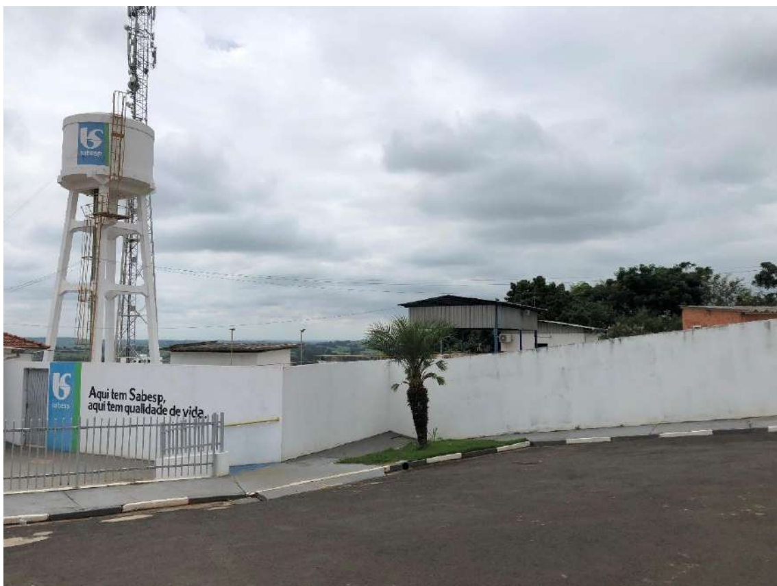
Figura 24 - Detalhe do reservatório 02 (ETA) na sede do município
