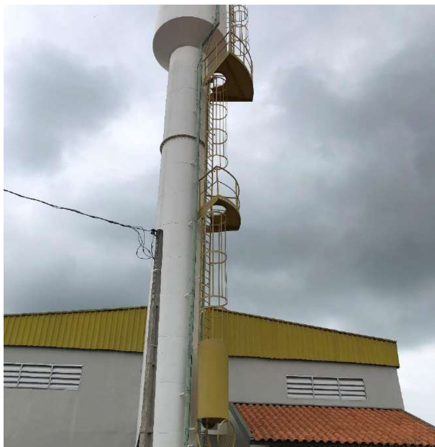
Figura 30 - Detalhe do reservatório 02 do Distrito de Maristela
