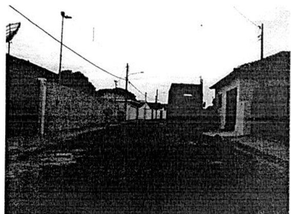
Foto 16. Rua José Pavan sentido Rua Adolfo Alves
