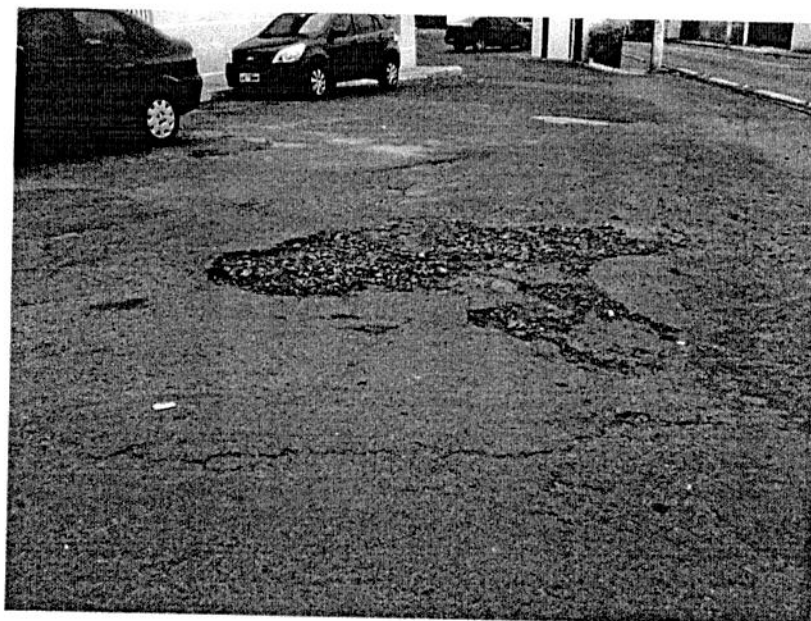
Figura 6. Vista Entroncamento Alameda Manoel Castanho com Av. Afonso Mathias
