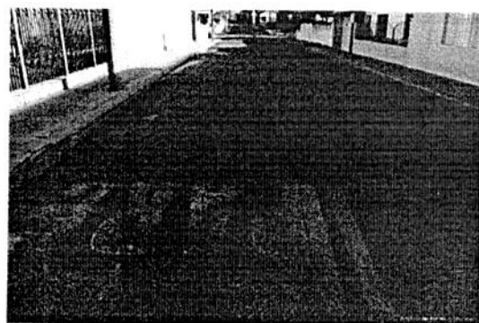
Foto 20. Rua Caetano Baffa sentido Praça Dr. Job Salto
