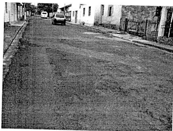
Foto 7. Alameda Manoel Castanho sentido Rua Adolfo Alves
