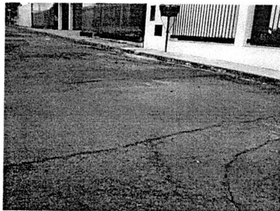
Foto 18. Rua José Pavan sentido Rua Adolfo Alves
