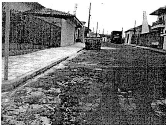
Foto 15. Rua José Pavan sentido Rua Adolfo Alves
