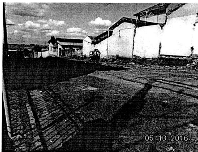
Figura 2. Vista Rua Irmã Conceição Maria - pavimentação e recape
