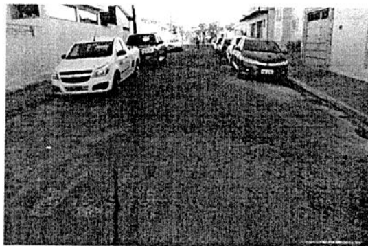
Foto 19. Rua Caetano Baffa sentido Praça Dr. Job Salto
